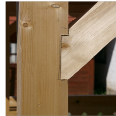
Detail „b“ (tesársky spoj konštrukcie stojky)
