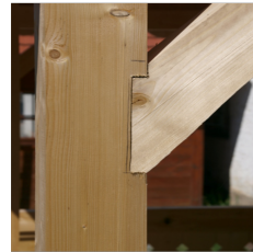
Detail „b“ (tesársky spoj konštrukcie stojky)
